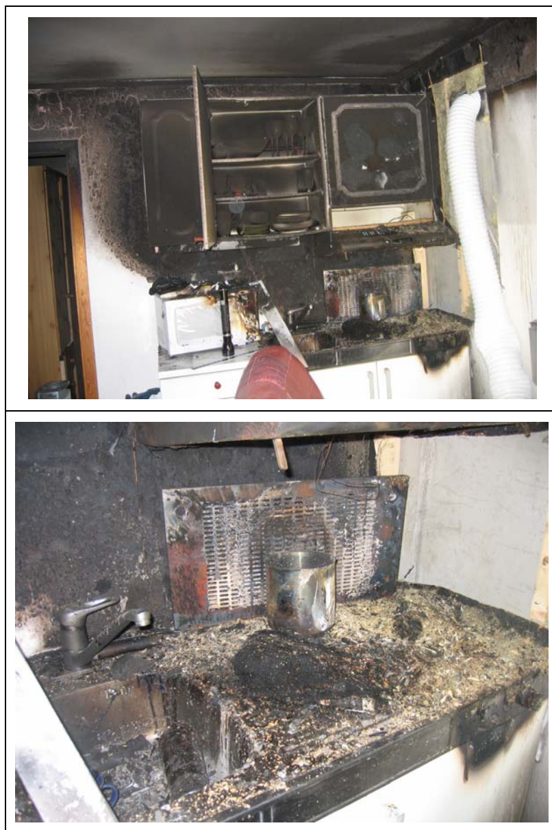
Figur 23 Brann i sokkelleilighet. Årsak: Tildekking av kokeplate.
